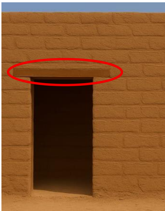
Image 4 : Disposition de linteau
