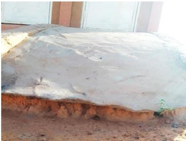
Figure 13 : Image de la pente d'accès à réhabiliter
