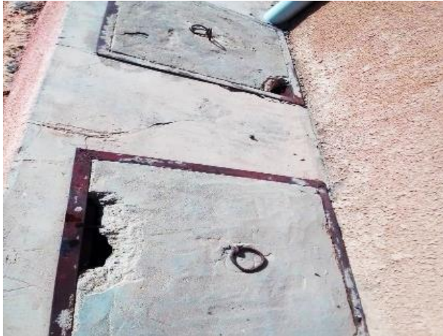
Figure 12 : Images des dalles à réhabiliter
